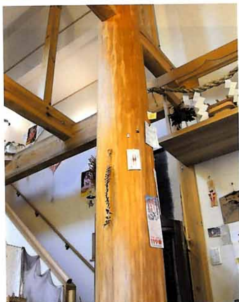
縦横に張り巡らされた表わしの梁(上)と、それを支えるスギの大黒柱(下)。いずれも施主が見守る中、森の原木から伐り出されたものだ。
